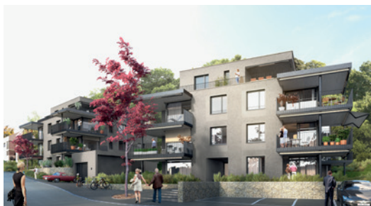
Austrasse, Arlesheim Eigentumswohnungen Flubacher Nyfeler Partner Architekten, Basel
