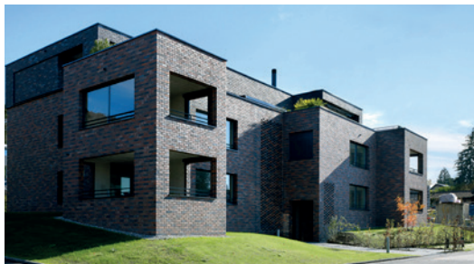
Bodenweg, Arlesheim Eigentumswohnungen Proplaning AG, Basel
