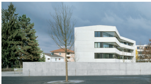
Langmattstrasse, Muttens Eigentumswohnungen Rosenmund + Rieder Architekten, Liestal
