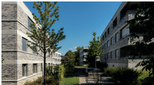
Im Kirschgarten, Binningen Eigentumswohnungen Müller & Naegelin Architekten BSA, Basel
