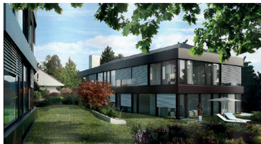
Faidostrasse, Basel Eigentumswohnungen Varem AG, Basel
